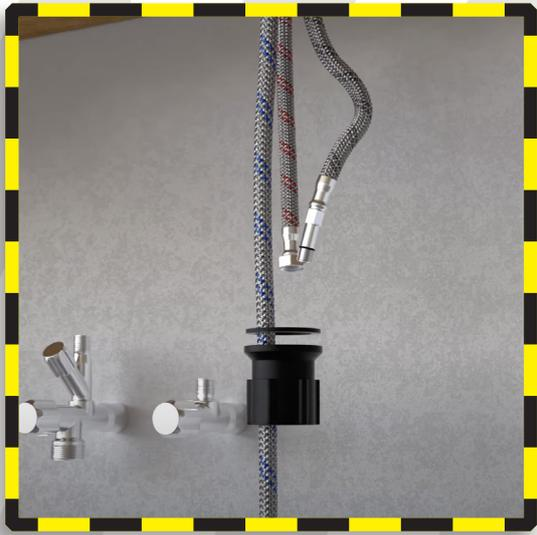
Führen Sie nun jeden Schlauch einzeln durch die Befestigungsmutter unter der Spüle und achten Sie darauf, dass Sie auch die Dichtung korrekt platzieren.
